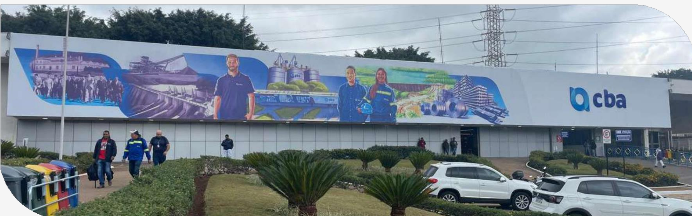
Trabalhadores foram surpreendidos com nova fachada na fábrica de Alumínio (SP), no dia 04/06
