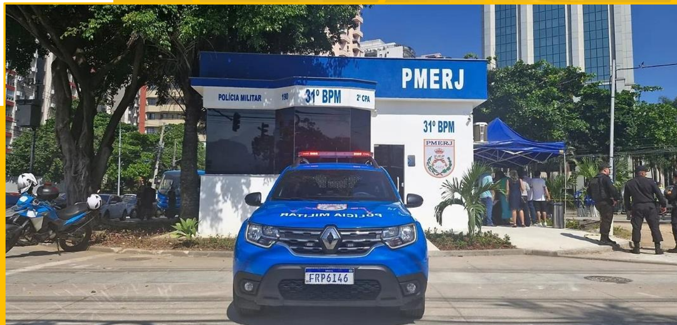
Guarita da Praça Pimentinha concluída
