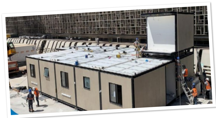
Construção de hospitais
